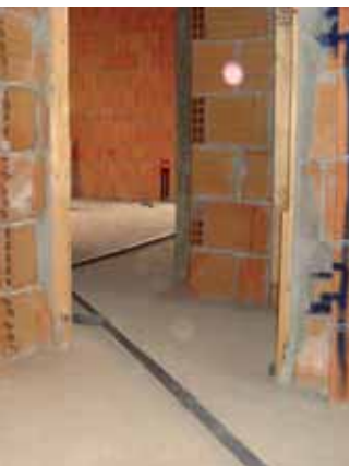
Particolare della posa della rete tubiera
