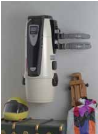
Posizionamento della centrale aspirante in un locale di servizio
